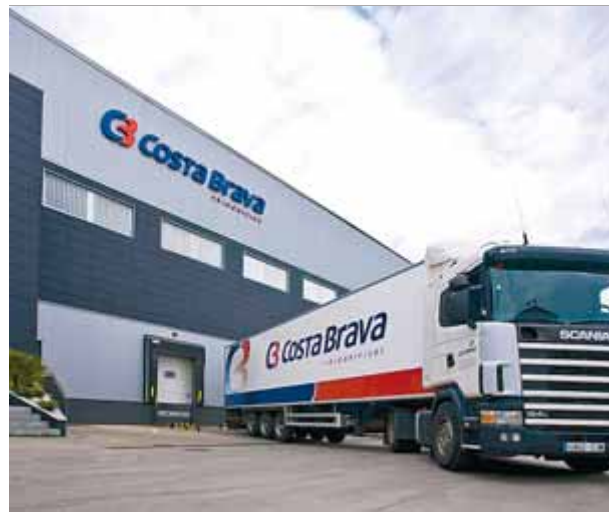
Instal·lacions de Frigorífics Costa Brava, a Riudellots de la Selva ■ EL PUNT AVUI
